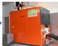
チップボイラー ハイツマート社製 (ドイツ)
